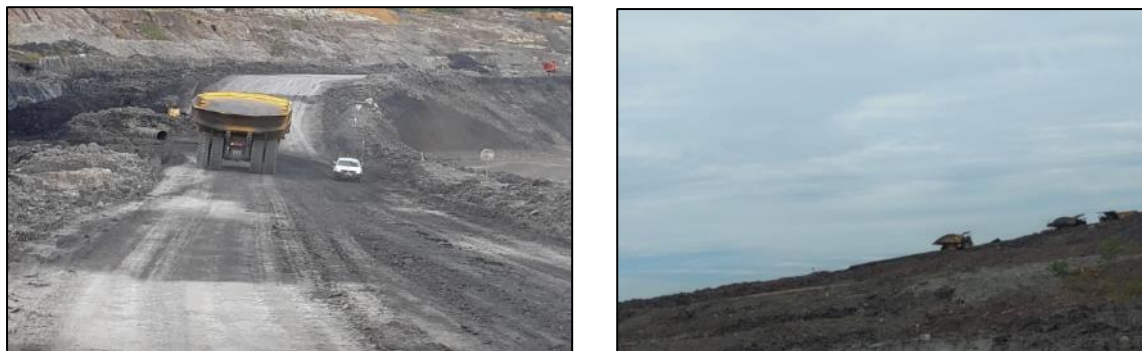
Gambar 1. Permasalahan geometri jalan tambang pada Jalan Highwall di PIT KGS. Penyempitan pada jalur trek lurus (kanan) dan grade jalan yang cukup tinggi (kiri).
