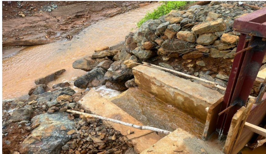
Gambar 6 Kondisi Outlet Settling Pond 1
