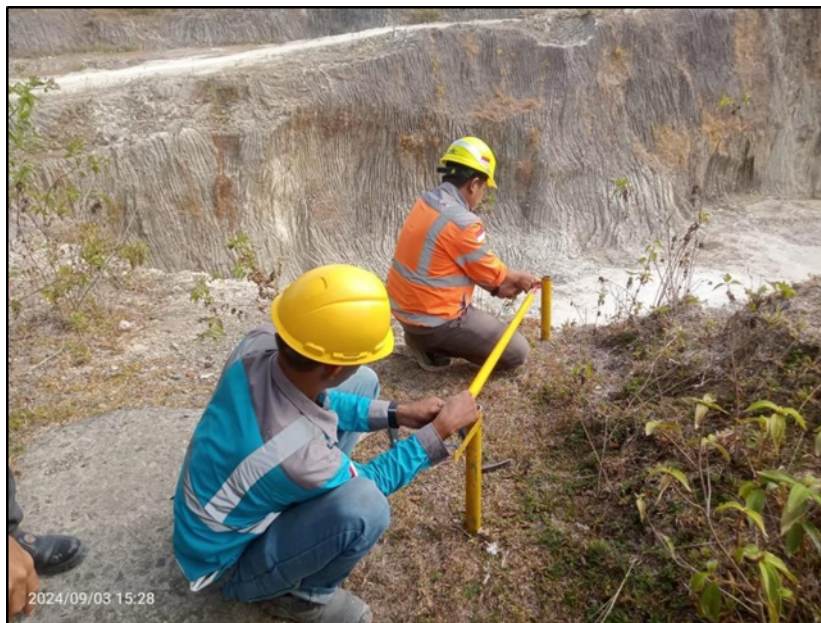
Gambar 8. Pemanatauan lereng dengan menggunakan Alat Crackmeter
