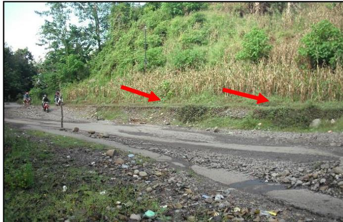
**Gambar 5 :** Kenampakan tinggi penurunan badan jalan akibat amblesan, difoto dari posisi menyudut badan jalan, saat ini tinggi penurunan  $\pm 1$  meter. Tanda panah menunjuk pada lokasi bukti tinggi pergeseran.
