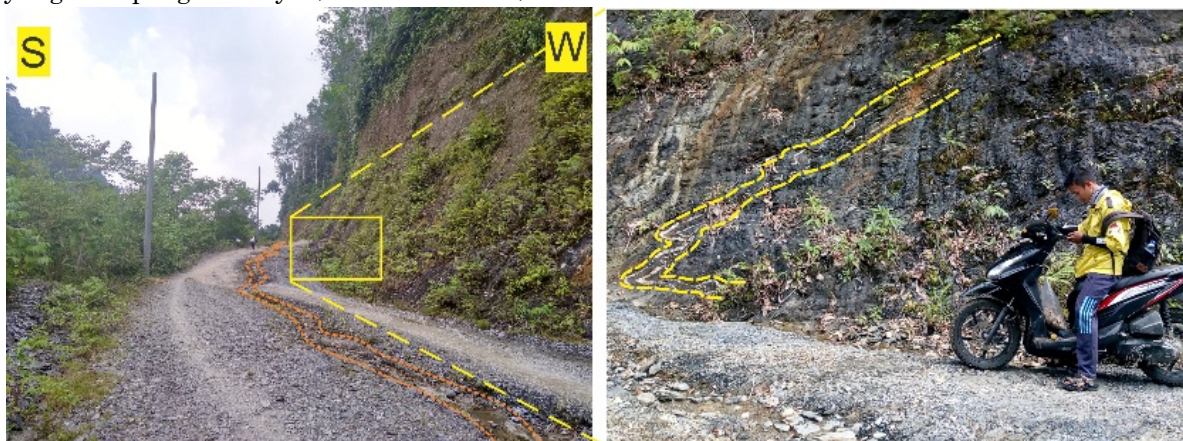
Gambar 8. Kondisi jalan di Desa Raden Anom, terdapat struktur microfold berorientasi NE-SW, litologi berupa filit.
