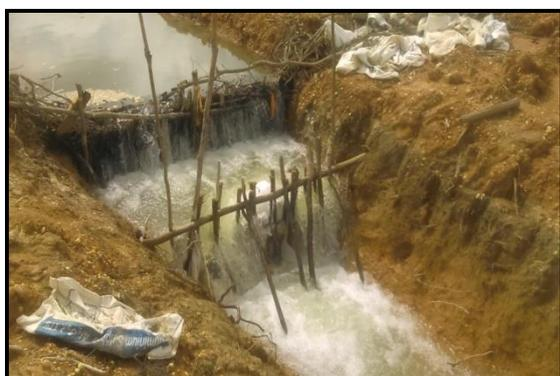
Gambar 4. Kondisi terjunan hidrolis untuk *rapid mixing*.
